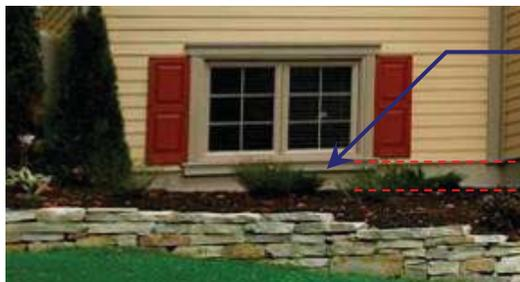
Laissez un minimum de 200 mm (8 po) de dégagement sous les fenêtres.
