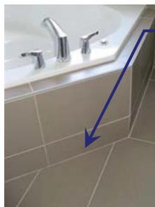
Des microfissures apparaissent souvent à la jonction des plans de céramique verticaux et horizontaux. Cette situation est normale et ne nuit pas à la solidité de l'assemblage.
