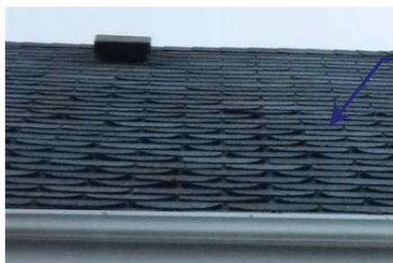
Bardeaux retroussés sous l'effet du soleil et du vent. Ils devront être remplacés sans délai.
