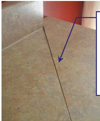
En montant sur les comptoirs, vous risquez de disloquer les joints des surfaces. L'eau risque ensuite de s'infiltrer entre le fini et le support de comptoir, ce qui provoquera un décollement et des boursofflures.
