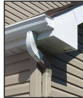
Au bas des descentes pluviales, l'eau doit être dirigée loin de la fondation. Dans le cas contraire, l'eau pourrait créer des dépressions où l'eau s'accumulera et vous risquerez des infiltrations d'eau. Il est donc important que le bas des descentes soit muni de coudes et, selon les pentes de votre terrain et l'endroit où l'eau devrait être dirigée, vous aurez peut-être aussi besoin d'installer des rallonges ou des blocs parapluie.
