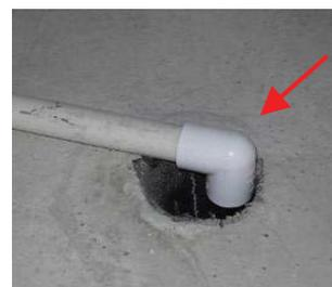
*Si vous avez un système de chauffage centralisé, vous pourriez constater la présence d'un conduit qui achemine l'eau de condensation vers un avaloir de sol. Vous ne devez pas déplacer ni écraser ce conduit.*
