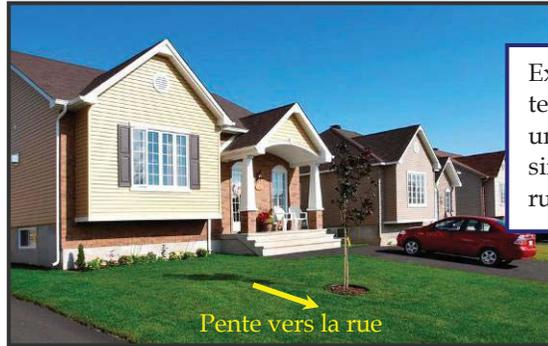
Exemple d'un terrain ayant un nivellement simple vers la rue
