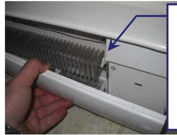
De petits bruits de craquement peuvent être entendus lors du fonctionnement d'une plinthe après un arrêt prolongé. Ces bruits sont normaux, mais peuvent être diminués en desserrant les vis de fixation de la plinthe.
