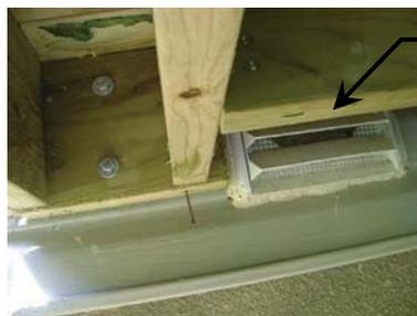
Une bouche d'extraction ou une prise d'air placée sous un balcon n'est pas une pratique adéquate.
