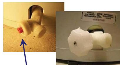
Sur certains chauffe-eaux, le robinet a la forme d'une poignée, et sur d'autres, il doit être ouvert avec un tournevis.
